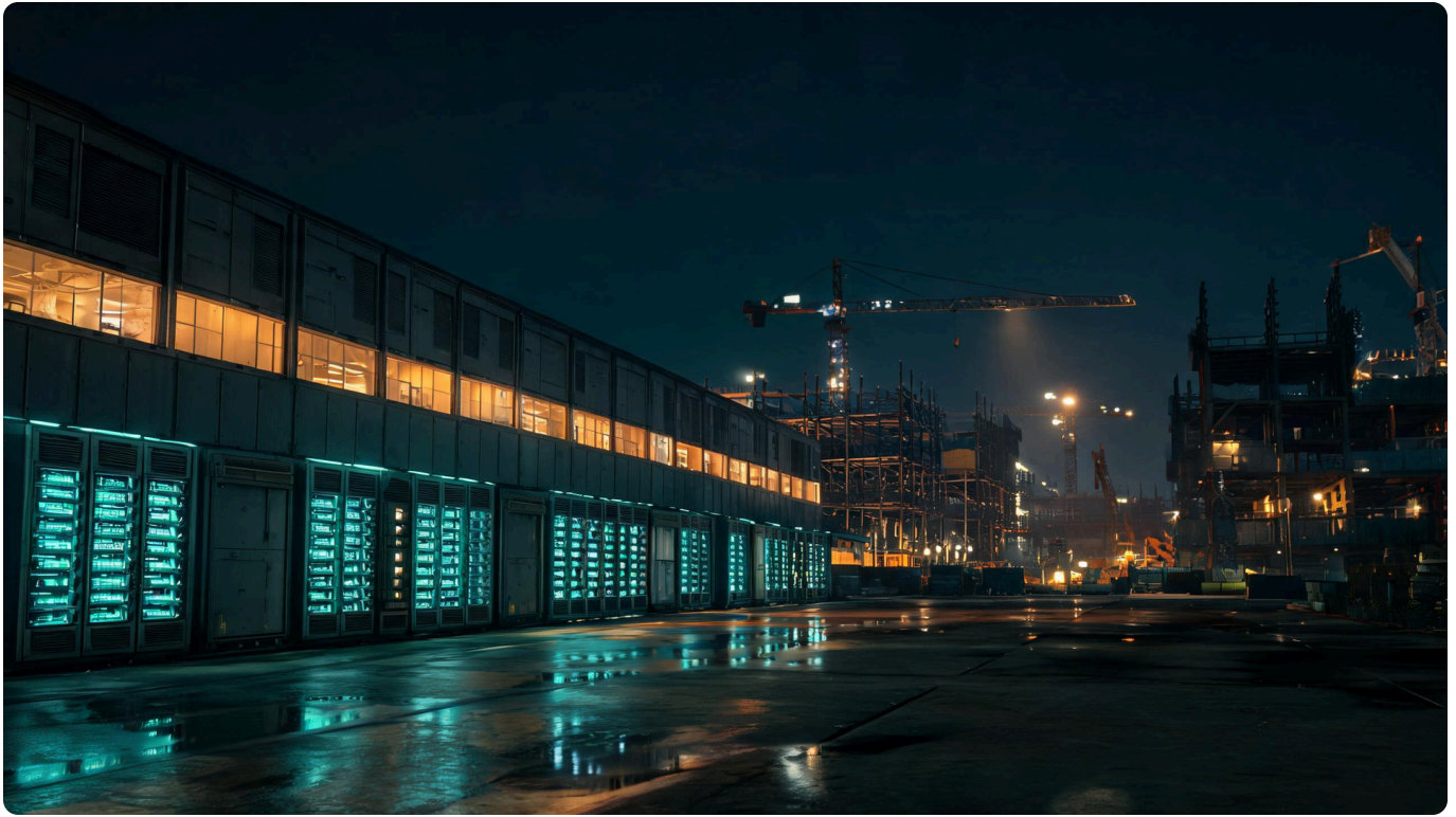
夜色中半座点亮、半座仍是钢骨架的数据中心园区
